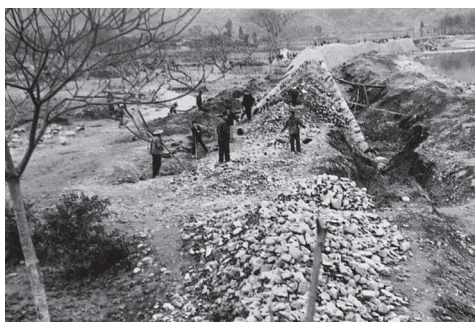
灾后正在重修的莒江防洪堤
