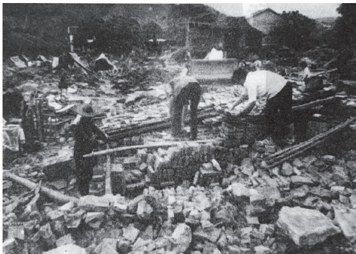
江口村被冲成一片废墟
