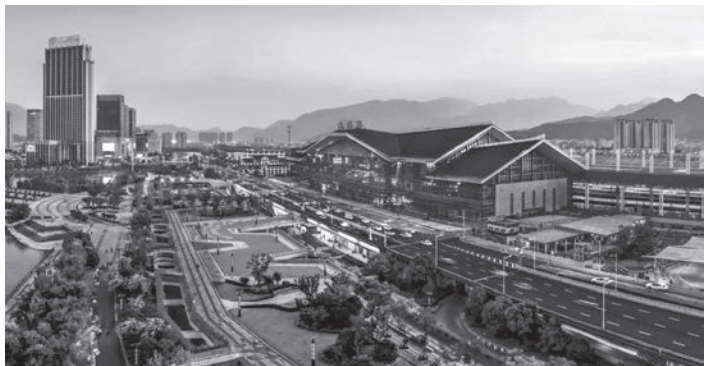
铁路温州南站（管新民/摄）
