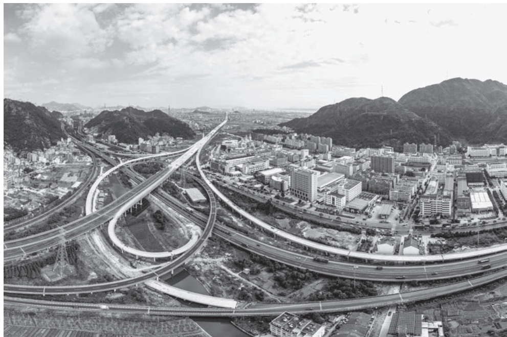
温州绕城高速公路北线二期工程
