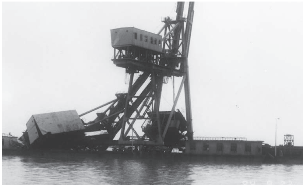
被台风吹垮的卸煤机
